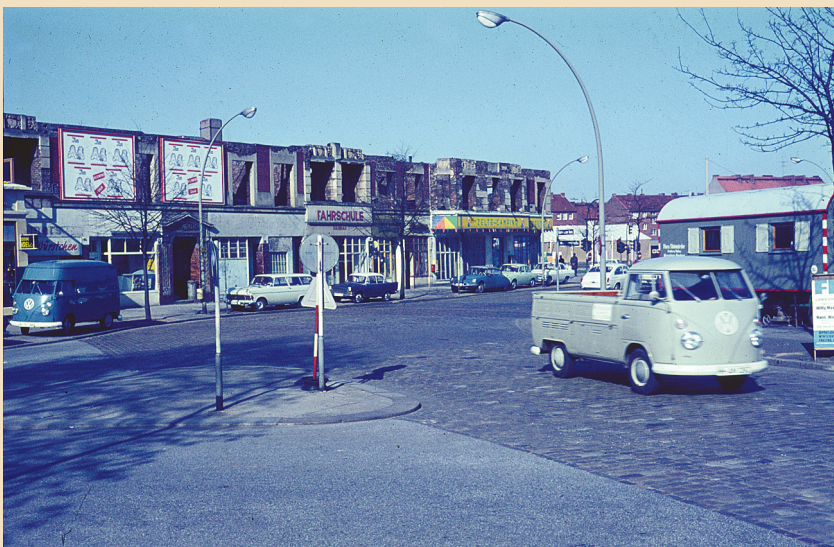
An der Wagnerstraße, gegenüber von Holsteinischen Kamp, stehen bis 1963 noch die Reste von 1943 zerstörten Etagenhäusern
